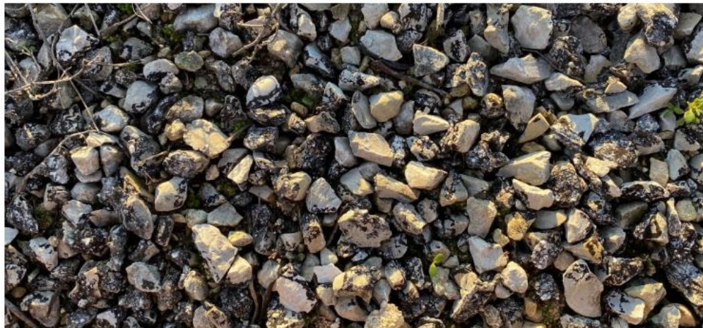
Aspect de l'asphalte gravillonné en surface sur le plateau
