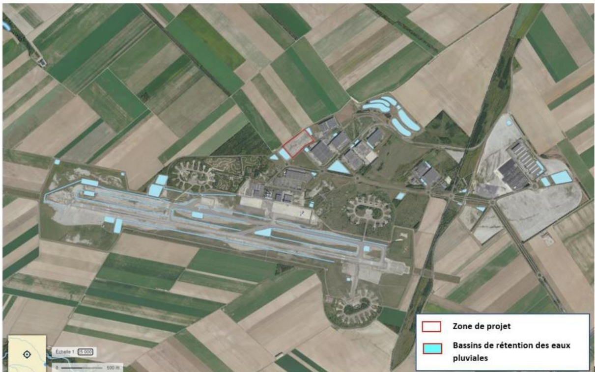
Les bassins de rétention et hydrographie en périphérie immédiate du site – Source : ECOSYSTEMES d'après GEOPORTAIL
